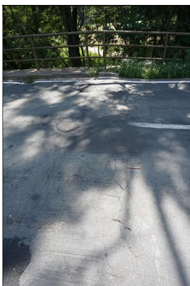
Stav vozovky na mostě u opěry OP1 - rozpad vozovky, mnohačetné trhliny, vyjeté koleje.
