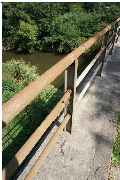
Detail levého zábradlí - rozpad vodorovné výplně.
