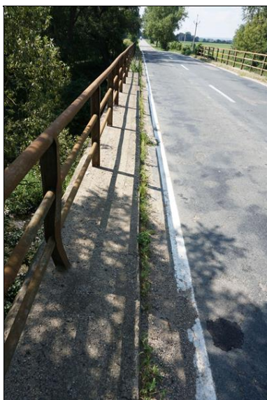
Deformace sloupku zábradlí na pravé straně mostu.
