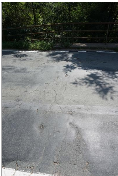
Stav vozovky na mostě u opěty OP3 - rozpad vozovky, mnohačetné trhliny, vyjeté koleje.
