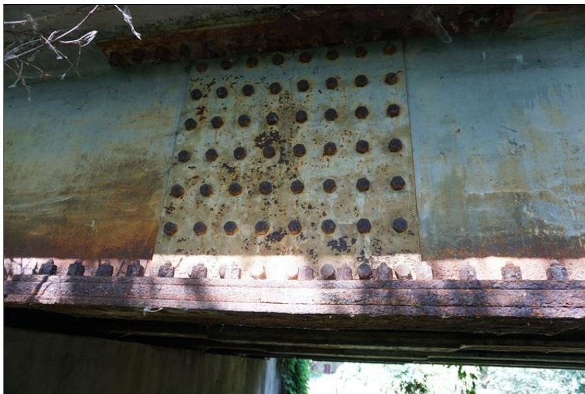
Detail styku hlavního nosníku nosné konstrukce u opěry OP1.
