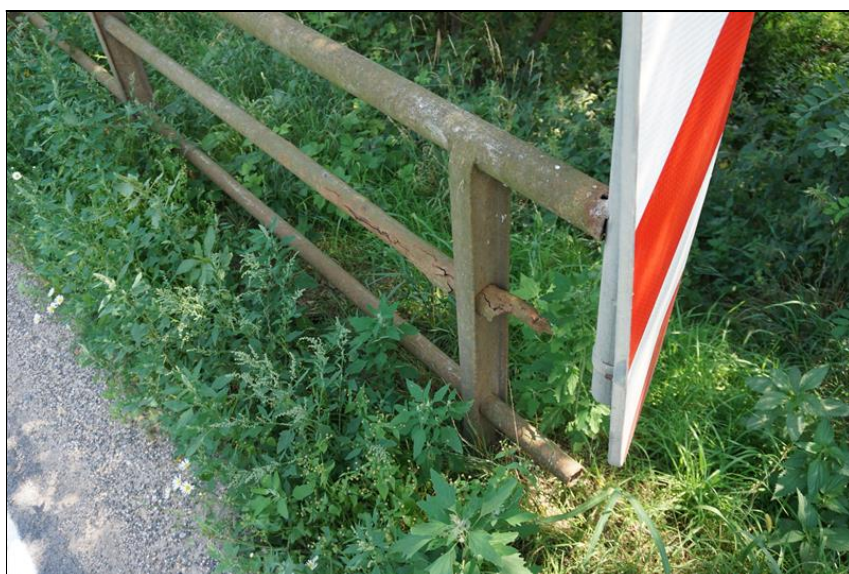
Detail pravého zábradlí u opěry OP1 - rozpad vodorovné výplně.
