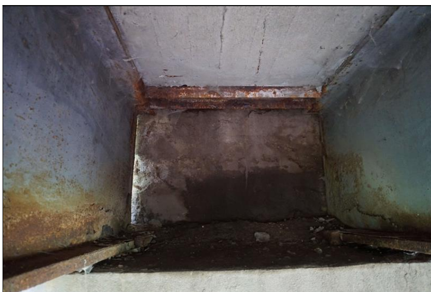
Detail úložného prahu opěry OP1
