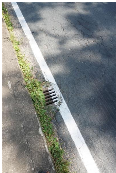
Detail odvodňovače na levé straně vozovky u opěry OP1.
