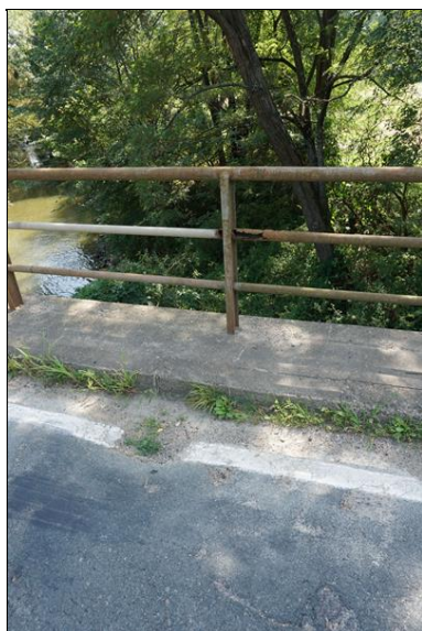
Detail pravého zábradlí - rozpad vodorovné výplně.
